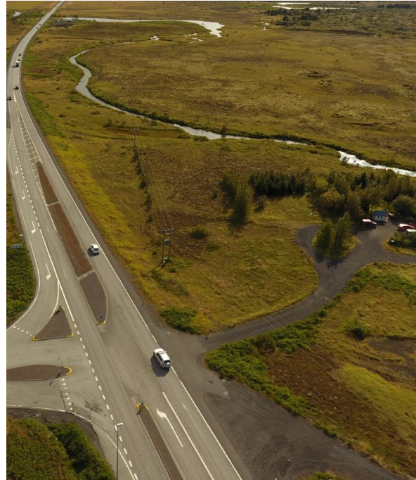
MYND 5.38 Séð til austurs frá vegamótum við Heiðmerkurveg. Hér liggur áin í góðri fjarlægð frá veginum (mynd EFLA).
