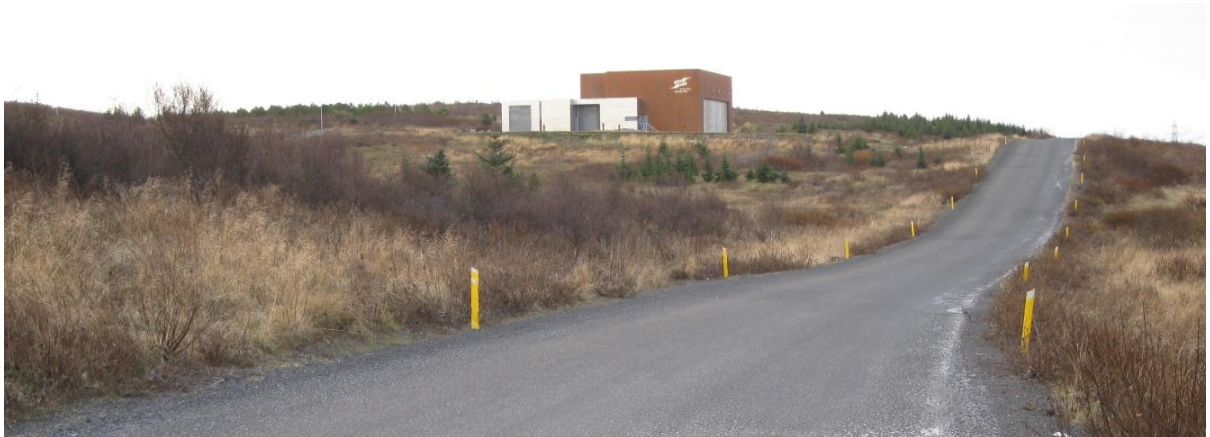
MYND 3.30 Vegbrekkur og aðveitustöð Veitna.
