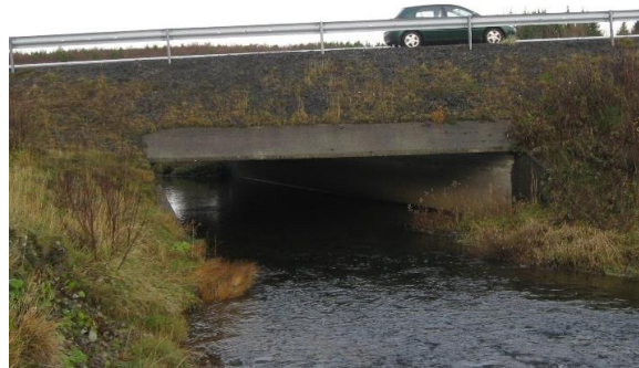
MYND 2.17 Brú yfir Bugðu í st. 6.340.
