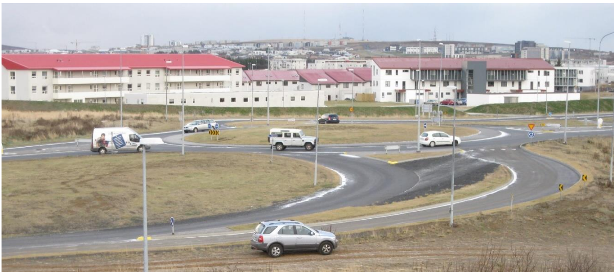
MYND 2.10 Hringtorg við Norðlingavað, Vegbrekkur nær.
