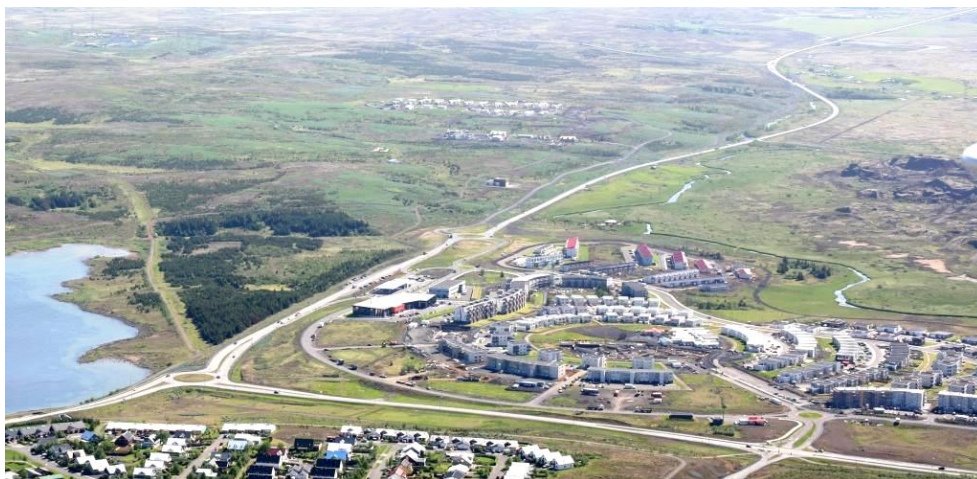
MYND 5.29 Horft til austurs yfir framkvæmdarsvæðið. Suðurlandsvegur liggur með Bugðu/Hólmsá og þverar ána þrisvar sinnum. (mynd EFLA).
